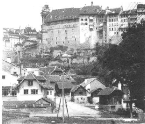
Les Grandes-Rames avant la construction de l'école
